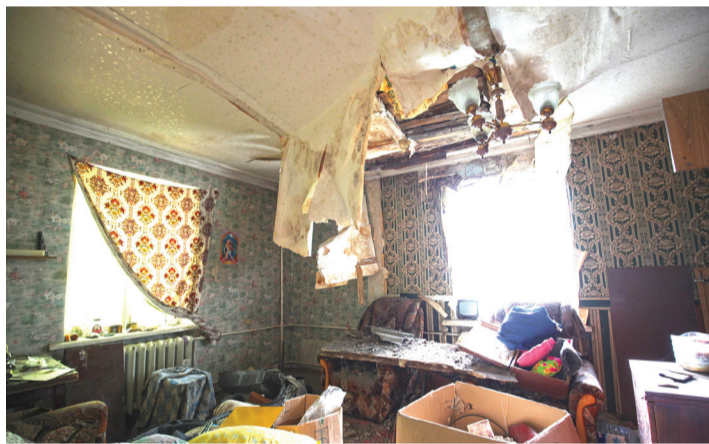
■ Потолок провис на добрые полметра и готов рухнуть.
